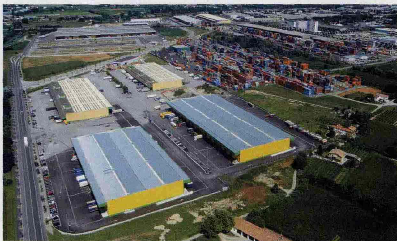
Presto sulle coperture di questi capannoni e magazzini dell'Interporto di Padova verrà prodotta corrente fotovoltaica per circa 16,5 gigawattora l'anno.
